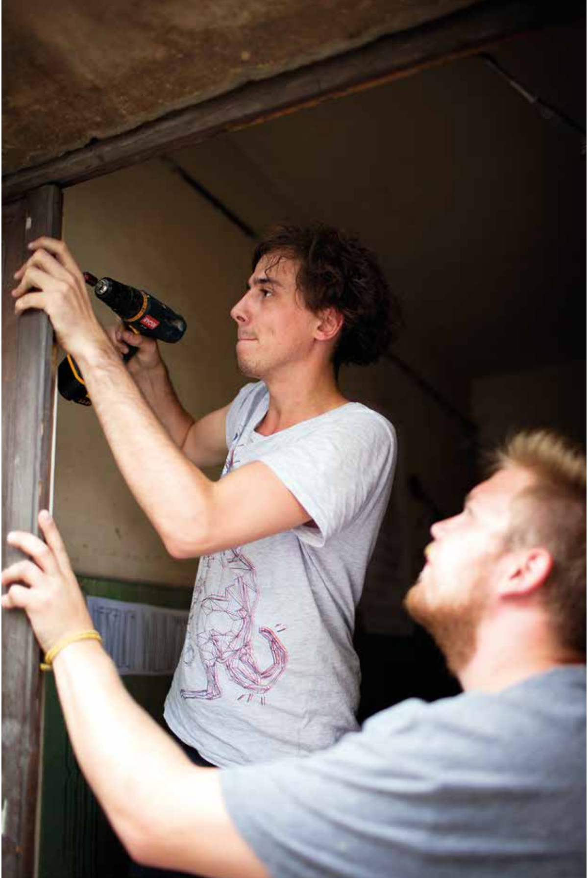
Abb. 10: Jugendliche setzen eigenverantwortlich Baumaßnahmen um
